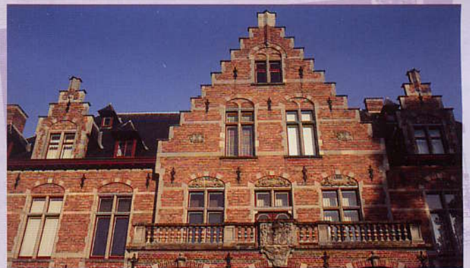
gevel kasteel de Herten
